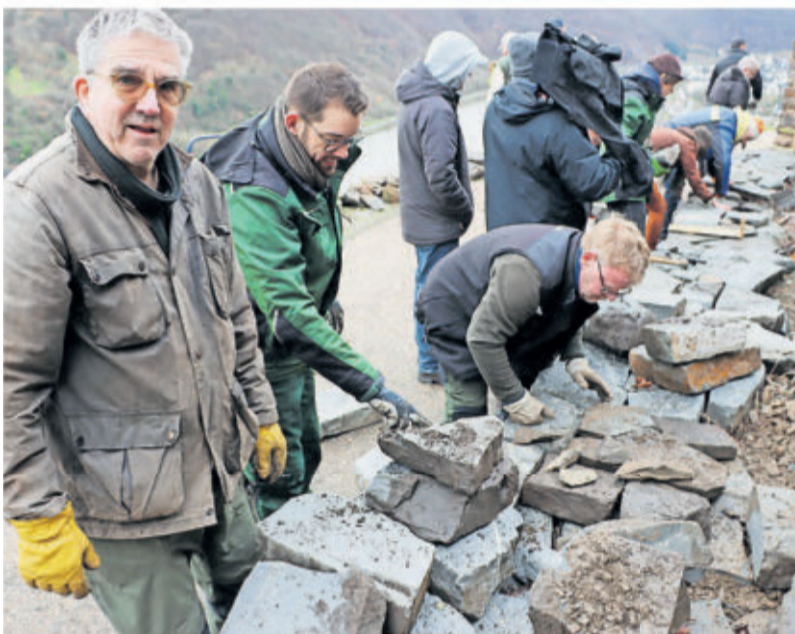
Viele Hände, schnelles Ende. Aber eine Trockenmauer zu bauen, ist mühsam und man braucht etwas Übung.
