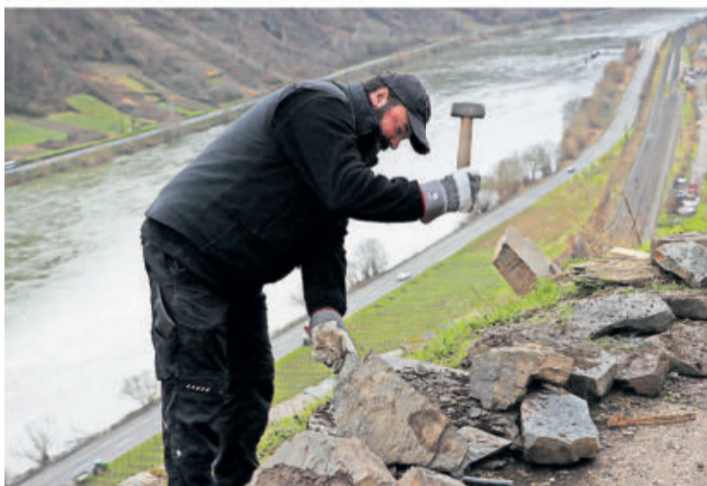
Alwanus passt einen Stein an, damit er in die Mauer passt.
