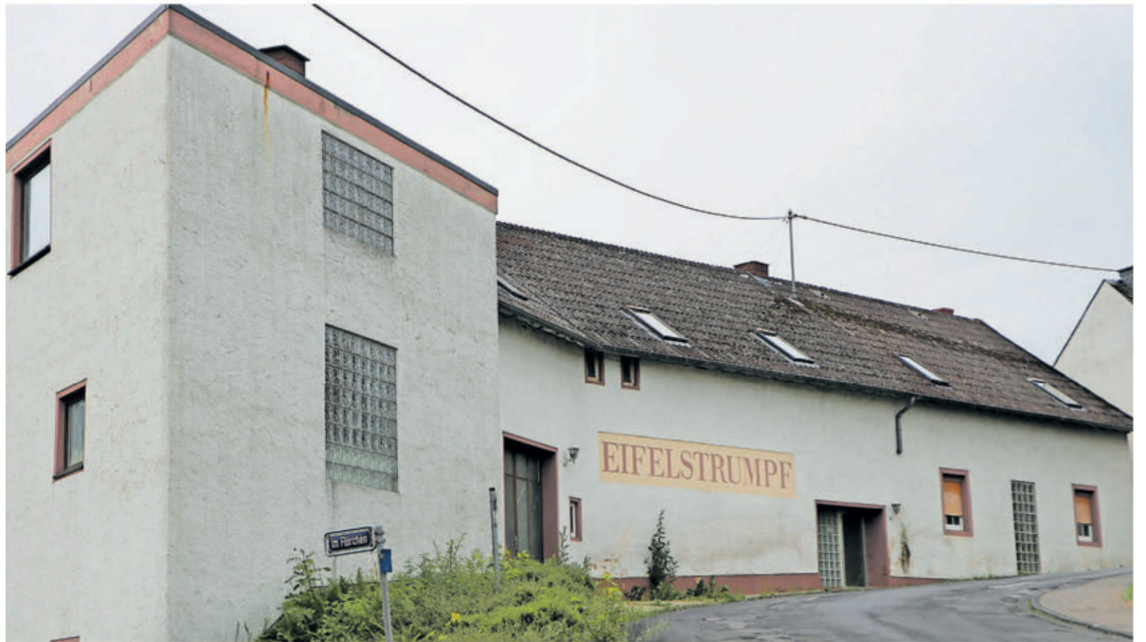
In diesem Werk wurden die Strümpfe gestrickt. Seit eineinhalb Jahren steht es leer. Der Besitzer wollte dort Wohnungen bauen.
