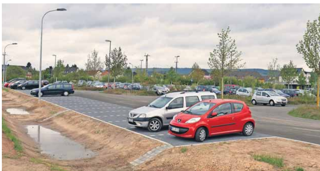
Mehr Platz: Am Bahnhof Wittlich-Wengerohr sind 126 neue Stellplätze entstanden. TV-FOTO: KLAUS KIMMLING
